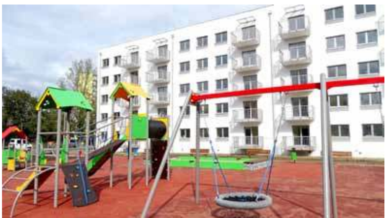
Nowoczesny, czteropiętrowy budynek z windą przeznaczony dla żołnierzy i ich rodzin ma łączną powierzchnię blisko 1870 m 2
