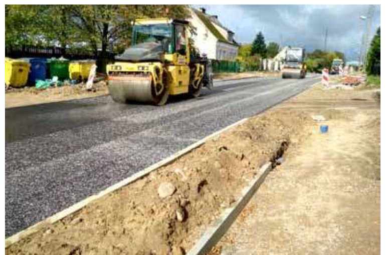
Od minionej soboty kierowcy mogą korzystać z przebudowanego odcinka ulicy Jana Pawła II
