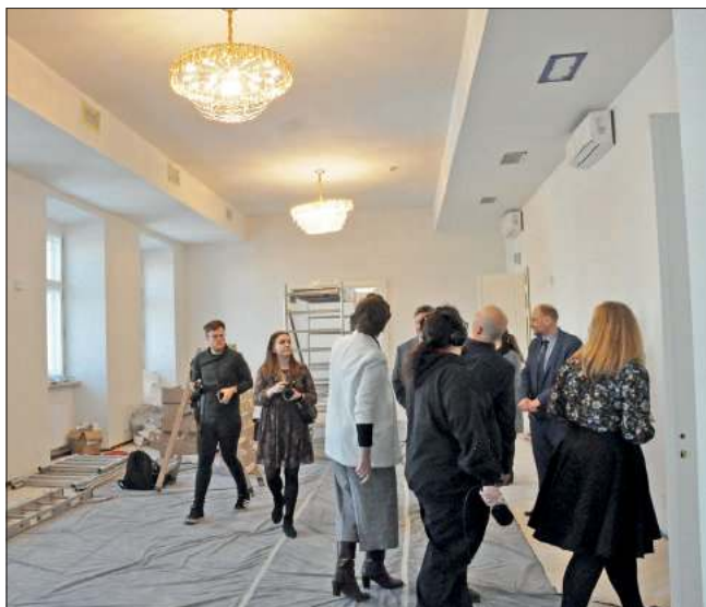
We wnętrzach pałacu trwają ostatnie prace wykończeniowe, które mogli obserwować dziennikarze podczas poniedziałkowej konferencji
