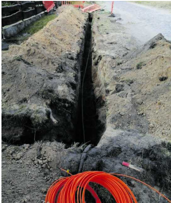
Prace realizowane w ramach PO PC przez Orange Polska w miejscowości Bonin.
