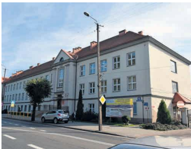
II Liceum Ogólnokształcące w Wieluniu nie zostanie zmodernizowane
