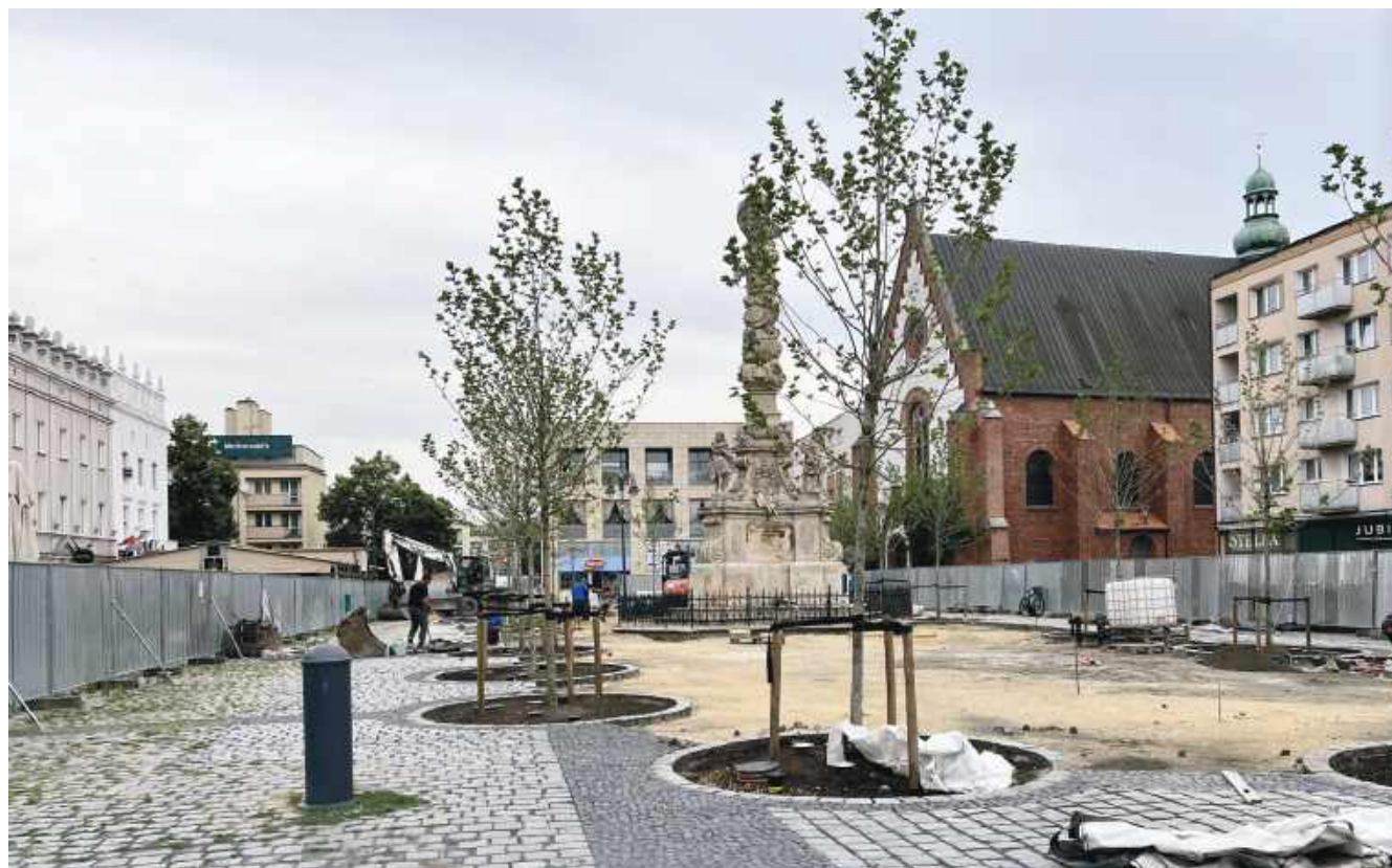
■ Rynek w Raciborzu w trakcie przebudowy – zdjęcie z 7 lipca 2026 roku
