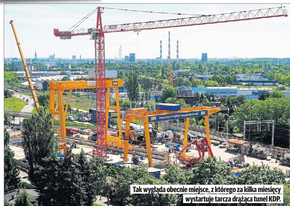
Komora startowa maszyny, która ma drążyć tunel KDP jest już gotowa. Teraz stanęła nad nią suwnica potrzebna do montażu tarczy drążącej.
