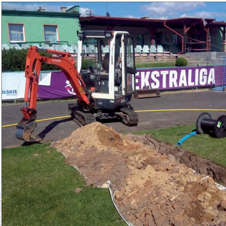
Prace na stadionie
