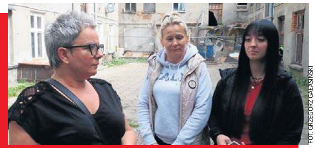
Mieszkanki kamienicy przy ul. Zgierskiej 74 obudził rano huk. Waliła się frontowa część budynku.
