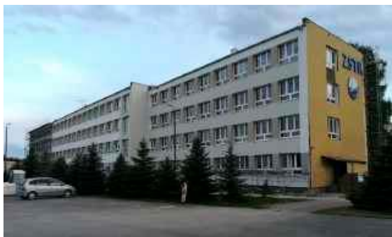
Szkoła „Kolejowa” już pozbyła się z elewacji nieestetyczną, blaszaną skorupę
