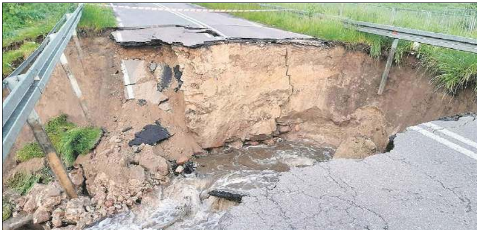
Ustawianie mostu zaczęło się w poniedziałek. W zależności od pogody potrwa od 10 do 14 dni
