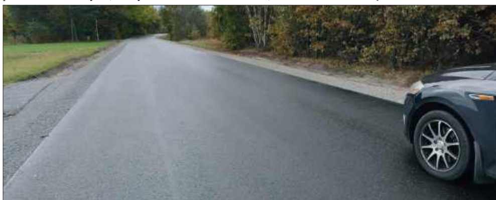
Nowo odremontowana nawierzchnia w Płazówce.
