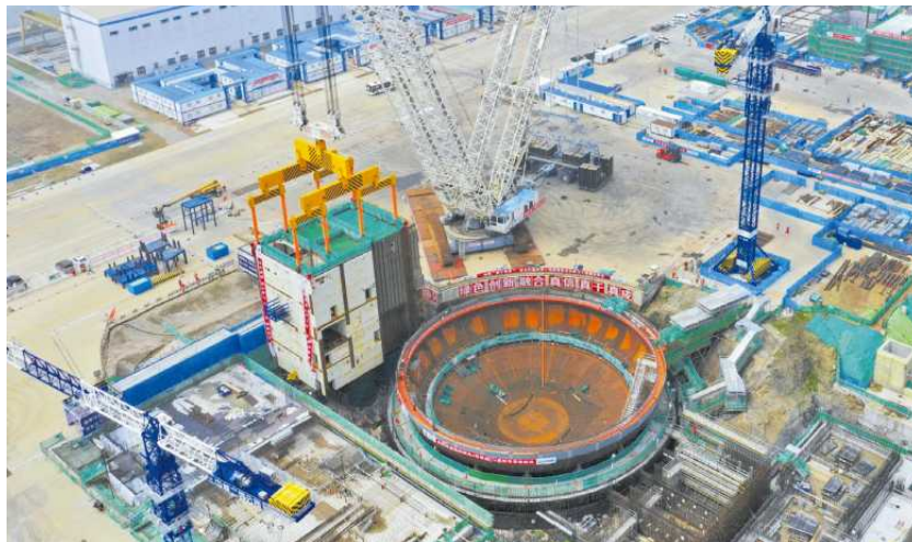
• Budowa elektrowni atomowej Haiyang w Chinach według projektu Westinghouse'u FOT. AFP/EAST NEWS
