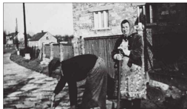
■ Remont drogi przy ul. Bończyka w 1962 roku przed domem Anny Hajduczek. Na zdjęciu kamieniarz Józef Kubny i jego pomocnica Leokadia Holubek.
