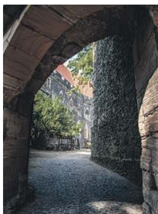
Frontowa ściana głównej części zamku od strony dziedzińca – widok przez jedną z bram
