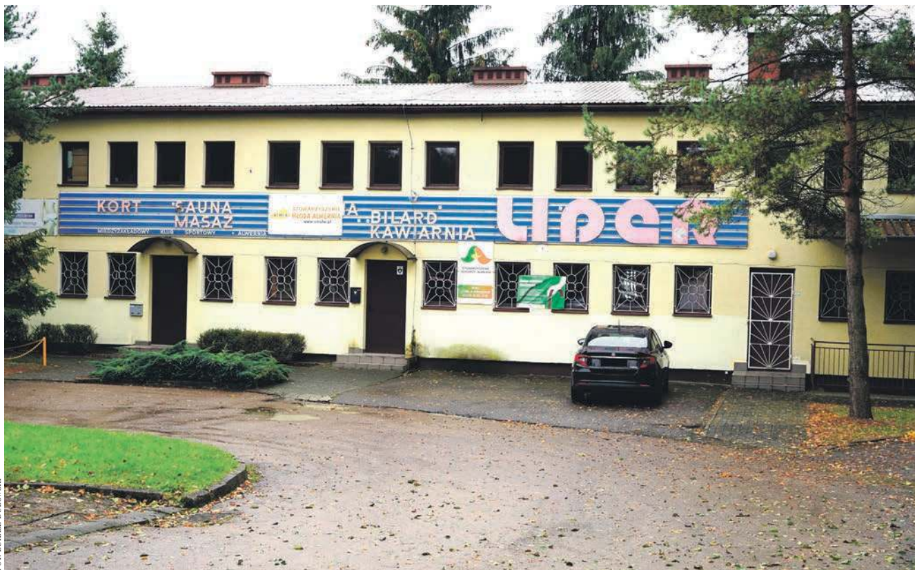
W budynku przy stadionie w Alwerni, w ramach nowego Centrum Usług Społecznych, ma powstać klub seniora
