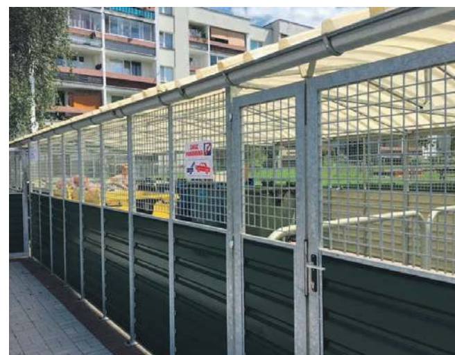
Zamykane stanowiska śmietnikowe nie są gwarancją, że mieszkańcy będą lepiej segregować, ale przynajmniej - że nikt z zewnątrz nie podrzuci odpadów
