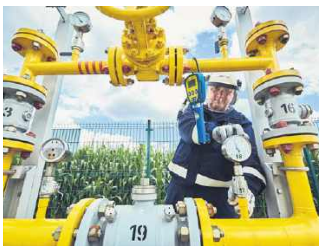
Budowa gazociągu - zdjęcia ilustracyjne, archiwum GAZ-SYSTEM
