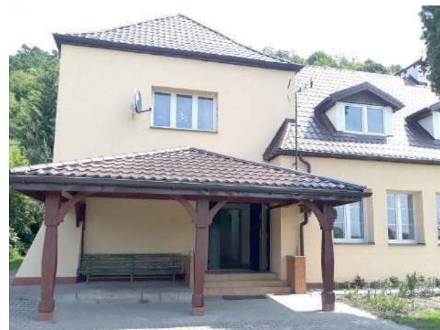
Na potrzeby Klubu Seniora + mają zostać oddane pomieszczenia świetlicy w Parchatce, które przeszły gruntowną przebudowę w 2017r. ze środków europejskich
