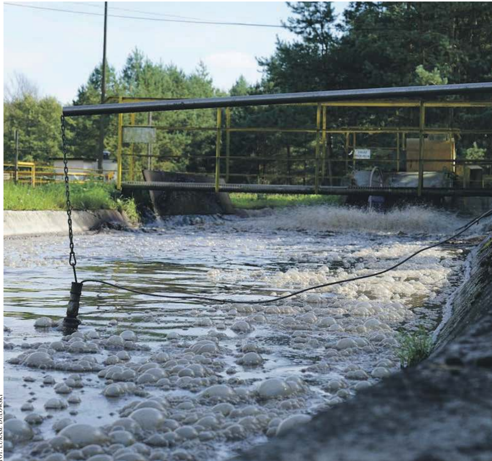
Stara oczyszczalnia ścieków znajduje się na terenie spółki Alventa (dawniej Zakłady Chemiczne Alwernia)
