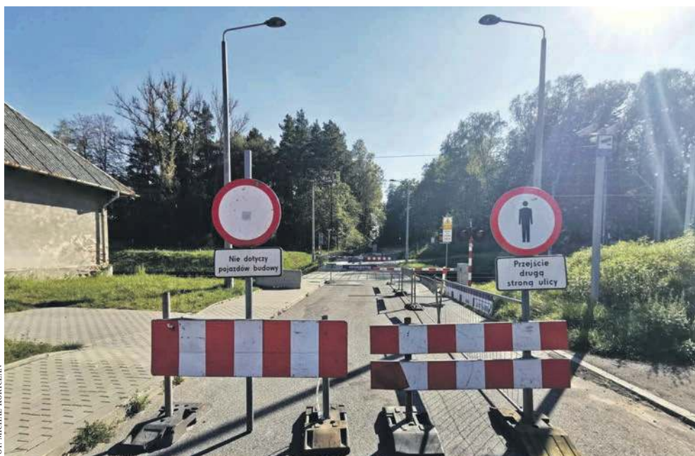
Przejazd kolejowy w Dulowej
