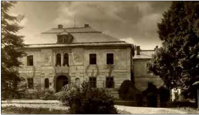
Fasada pałacu rodu von Gaschin w Kietrze.
