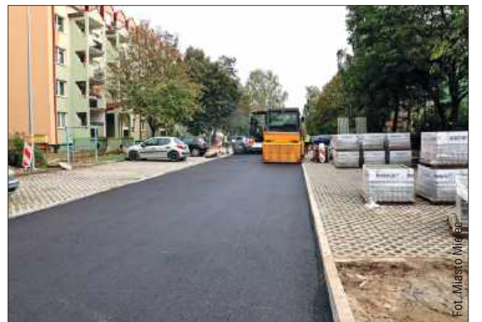
Trwające prace na Warneńczyka
