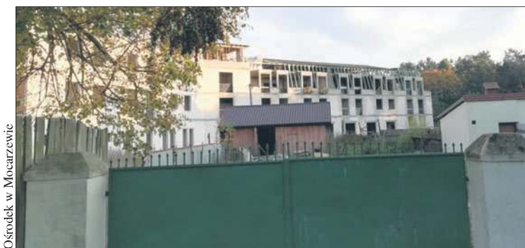
W trzypiętrowym budynku zainstalowano już pierwsze okna
