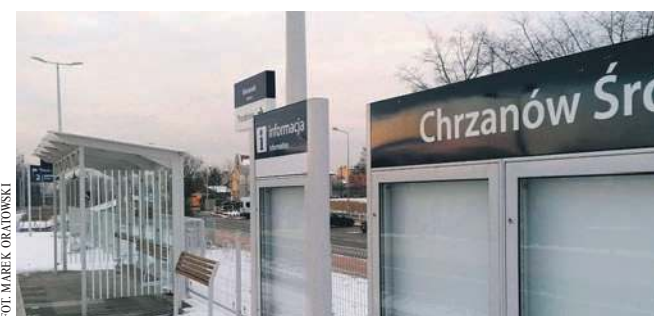
Przebudowany peron wygląda znacznie nowocześniej
