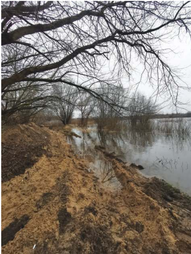
Droga dojazdowa została wytyczona na samym brzegu rzeki. Pytanie czy przy wyższym stanie wody nie będzie zalewana?
