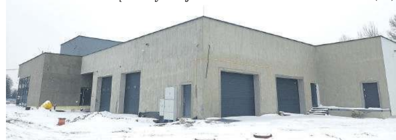
Centrum Kultury w Zaleszanach w budowie
