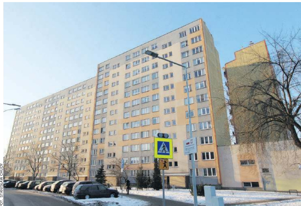
W 2024 r. na dachu tego wieżowca ma stanąć instalacja fotowoltaiczna, a w 8 klatkach schodowych mają działać nowe windy, zjeżdżające do poziomu 0
