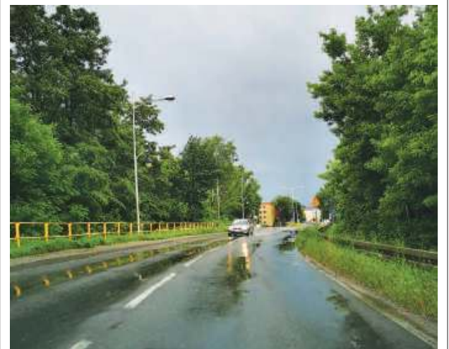
Na ul. Morawicza po deszczu tworzą się głębokie kałuże
