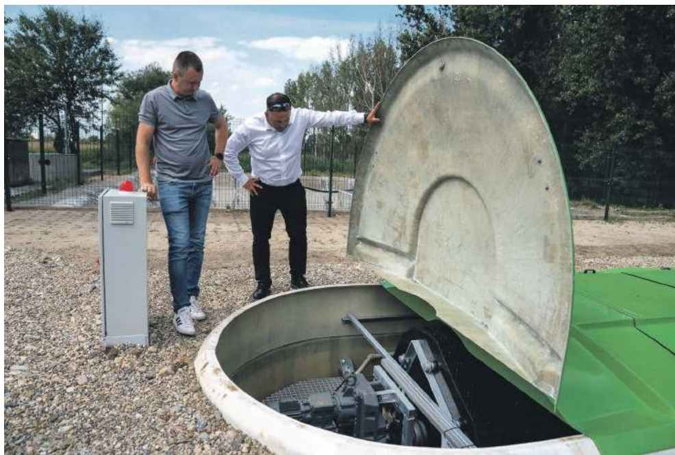
Budowana oczyszczalnia w Brzeźnie będzie nowoczesna i wydajna
