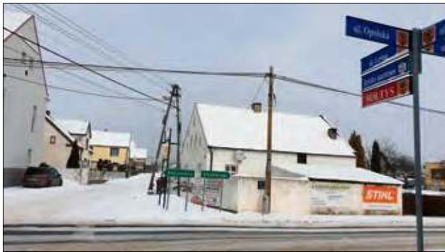
Leśna i Boczna w Raławiczkach to kolejne drogi, które wyremontuje gmina.
