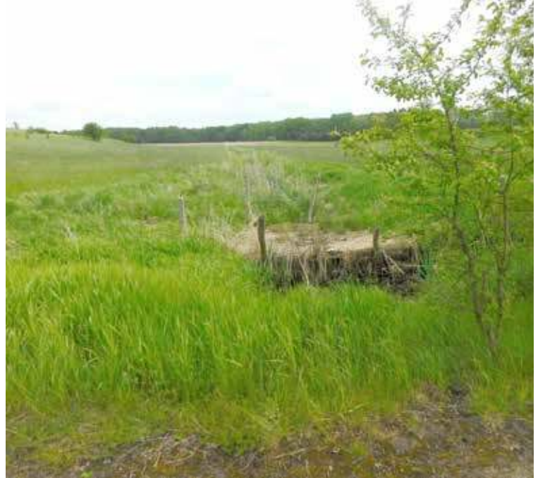
Zarwany mostek i dalej widoczny ślad zarośniętego rowu melioracyjnego. Dolina za byłą cegielnią na Radosławiu
