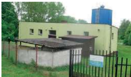
Studnia i stacja uzdatniania wody w Trzcińcu. Obok ma być zbudowana kolejna studnia
