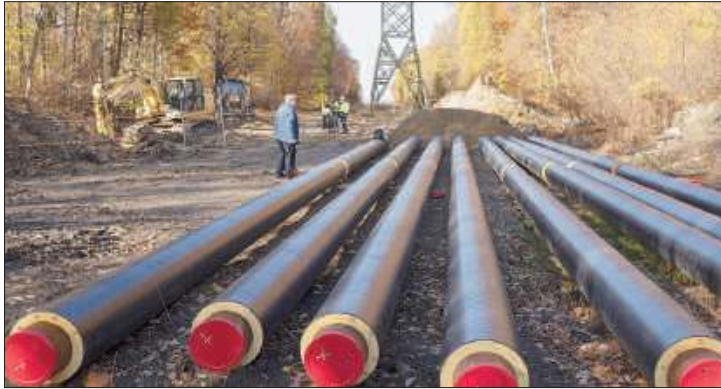
Budowa sieci ciepłowniczej dla Rokitnicy i Helenki
