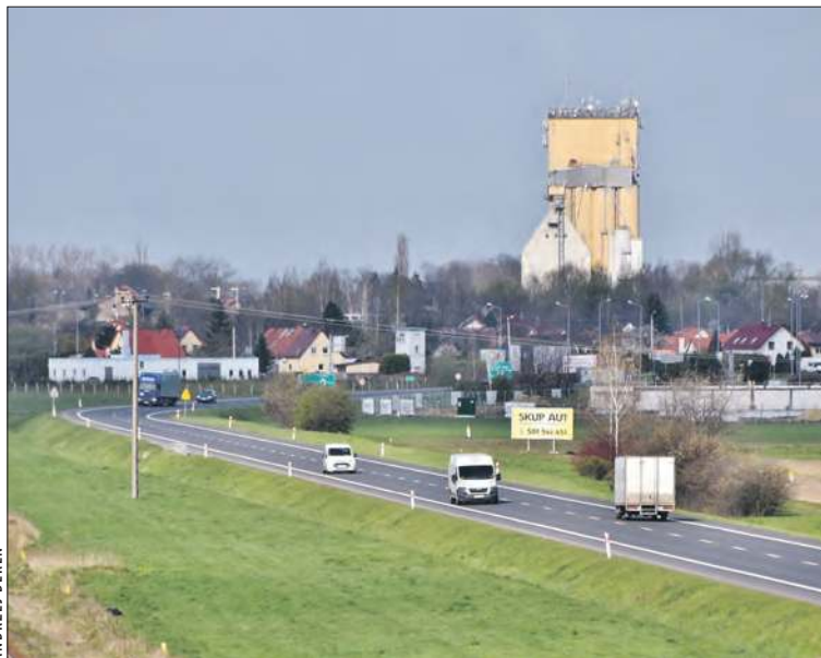
Nowa obwodnica połączona zostanie z obwodnicą Lubrzy
