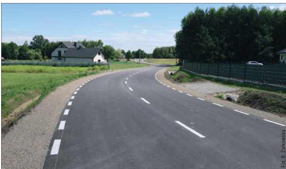
Nowo przebudowana droga powiatowa Kłapówka – Pogwizdów – Hucisko.
