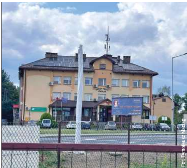
Aktualnie trwa montaż nowego urządzenia rejestrującego prędkość.
