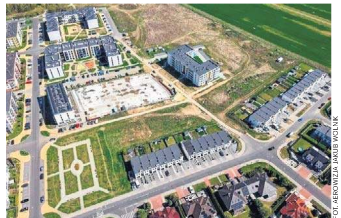
Drogi inwestycyjne na Nowym Piastowie w Głogowie. Okolica się rozwija, budowa dróg jest koniecznością.
