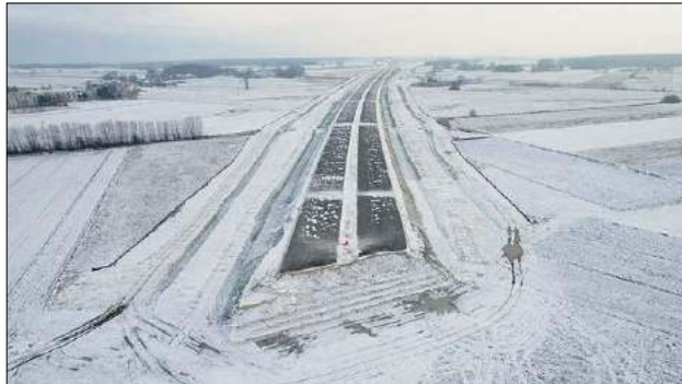
Najbardziej zaawansowane prace są na odcinku Swory – Biała Podlaska. Tam zaawansowanie prac projektowych jest na poziomie 97 proc., a zaawansowanie robót wynosi prawie 80 proc.
