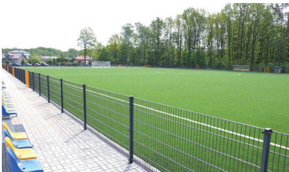
Tak prezentuje się nowy obiekt sportowy w Poniatowej, na którym aktualnie trwają prace porządkowe i inwentaryzacyjne
