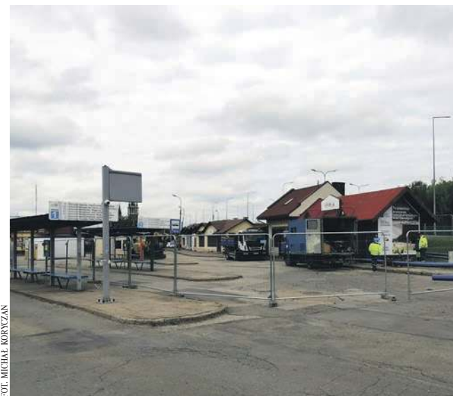
W tym miejscu powstanie centrum przesiadkowe
