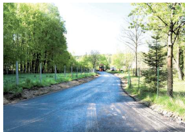
Równa droga ułatwi mieszkańcom dojazd do pól i budynków mieszkalnych
