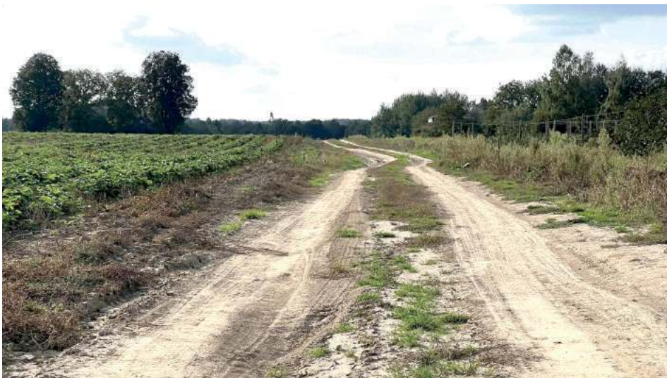
O budowę drogi z prawdziwego zdarzenia mieszkańcy Celejowa wspierani przez radnych zabiegali od kilku lat. Dzięki pozyskanej przez gminie dotacji ich marzenie o komfortowym dojeździe do domu stało się realne
