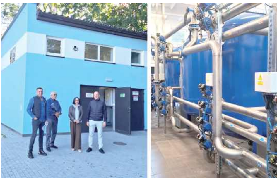
Stacja uzdatniania wody w Żelechowie została przebudowana
