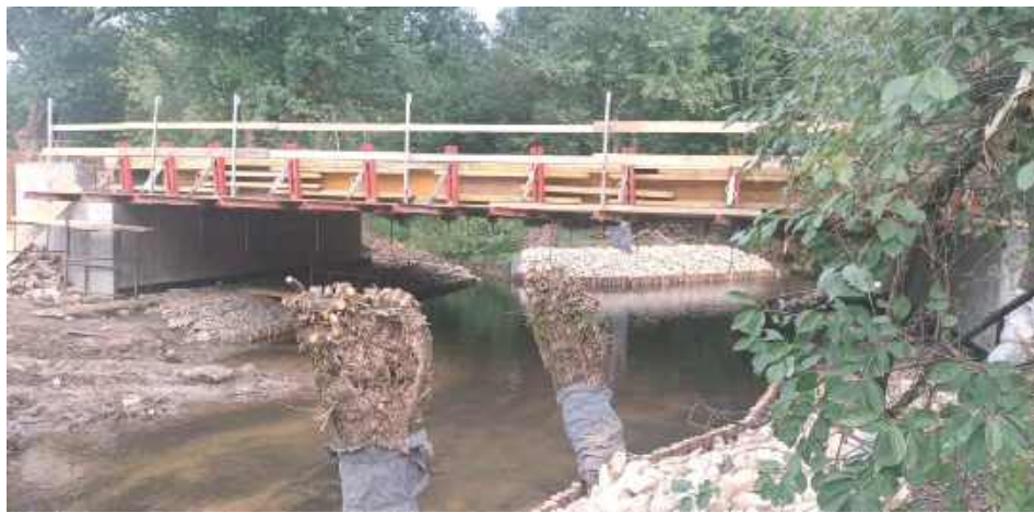
Trwają prace przy budowie nowego mostu
