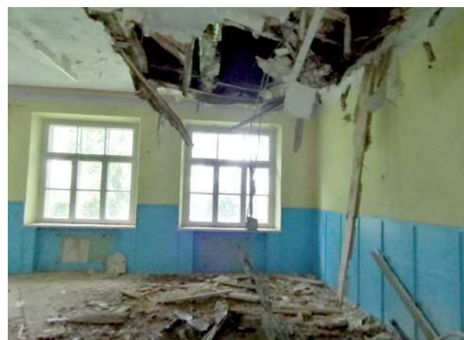
W najgorszym stanie jest stara część szkoły. Tu praktycznie w każdym pomieszczeniu strop zaczął się już zawalać
