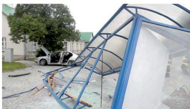
Wiatra przystankowa w Kamionce po uderzeniu rozpędzonego samochodu
