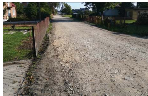
Ulica Okrzei została wyrównana i utwardzona przez wykonawcę kanalizacji
