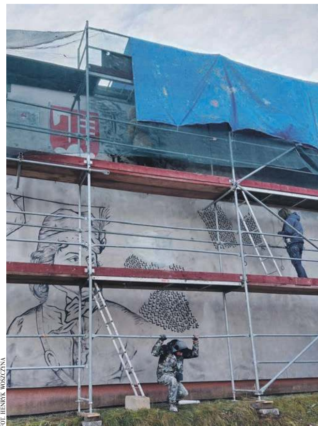
(ea) Trwają prace przy malowaniu ściany szkoły
