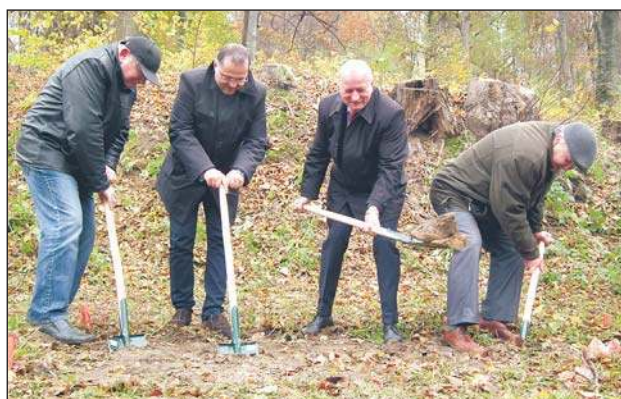
ŁOPATY ROKU - wbite pod budowę przychodni w Łatoszynie.
