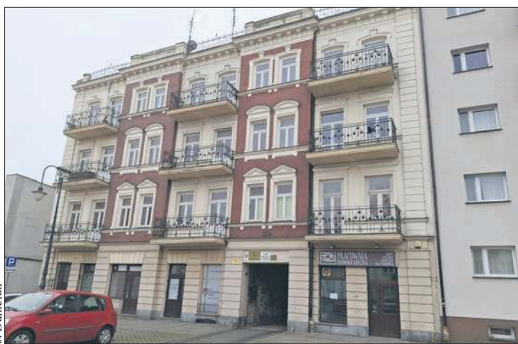
Kamienica przy ul. Kwiatka 9
