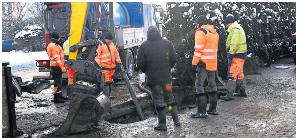
Usuwanie awarii pękniętego rurociągu w Sławnie
