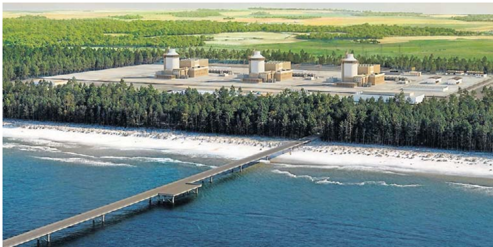
Pomost będzie służył do przeładunku wielkogabarytowych elementów
