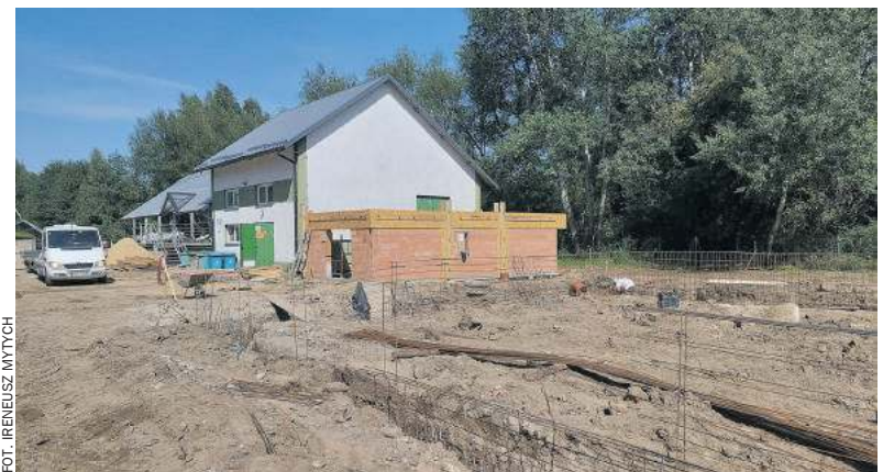
Trwają prace modernizacyjne oczyszczalni ścieków w Zaklikowie
