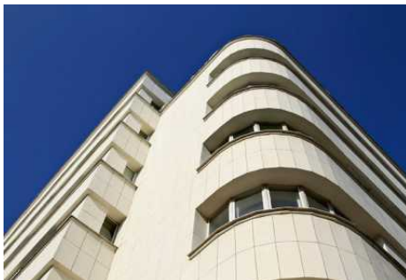
• Kamienica przy ulicy Świętojańskiej 68
