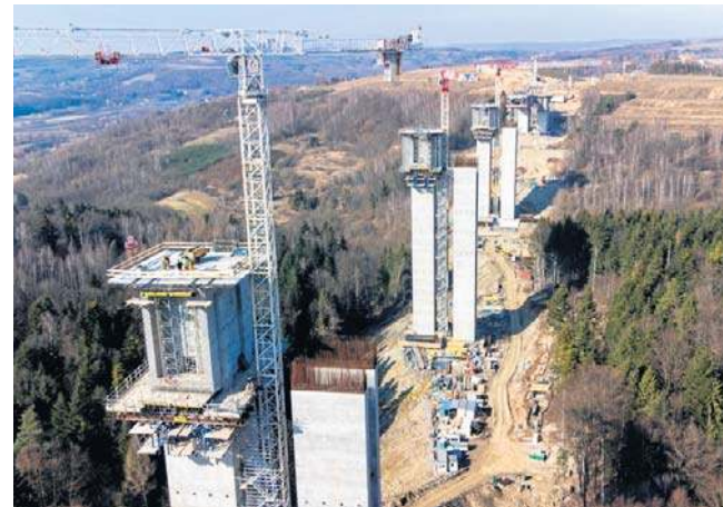
Najwyższy filar estakady na odcinku S19 Babica-Jawornik osiągnął 80 metrów wysokości
