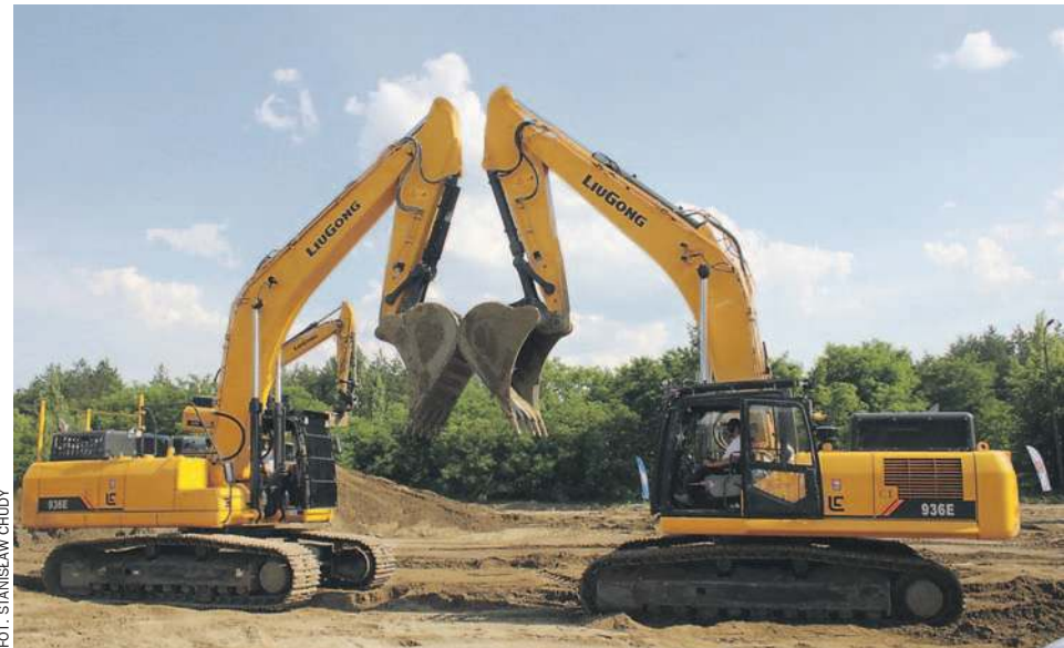
Stalowa Wola, czerwiec 2018 r. Efektowne popisy koparek z LiuGong Dressta Machinery
