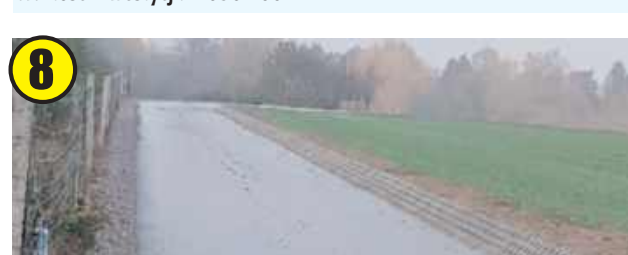
Przebudowa drogi Zagajdzie - Rogów - Wólka Polanowska - Kosiorów na odcinku w Rogowie (dł. 768 m)
